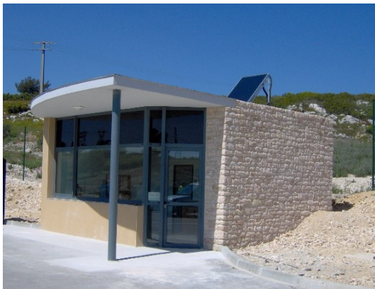
Bâtiment d'accueil de la déchèterie du Vallon du Fou
