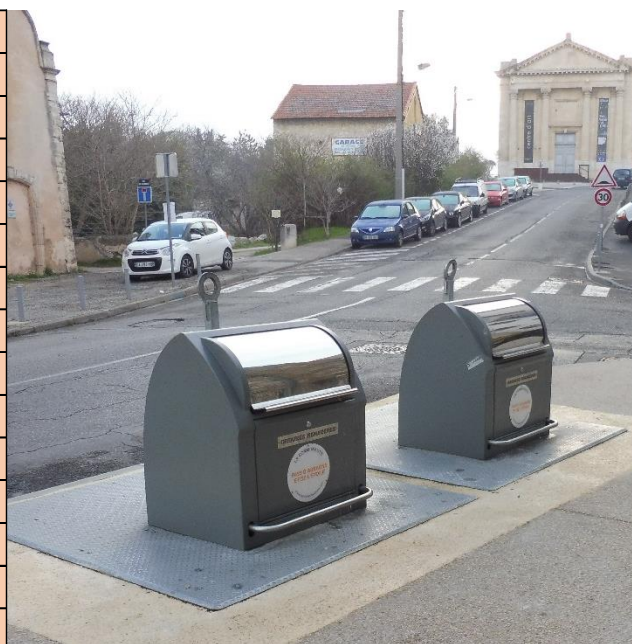
Conteneurs enterrés pour les ordures ménagères
