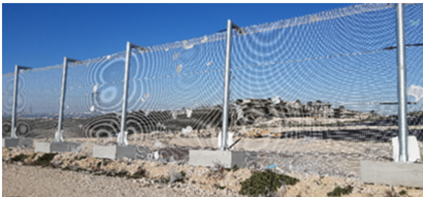
Filets anti-envols 250 ml – Flanc Sud alvéole n°3 (ISDND du Vallon du Fou)
