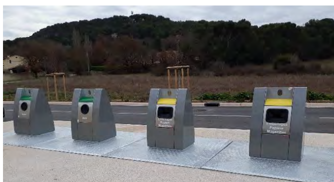
Dispositif enterré Commune de Cabriès
