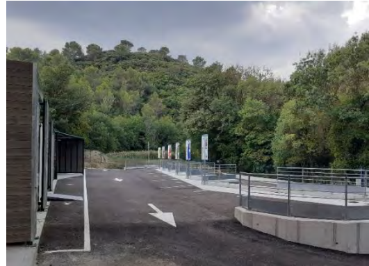
Haut de quais de la déchèterie Commune de Vauvenargues
