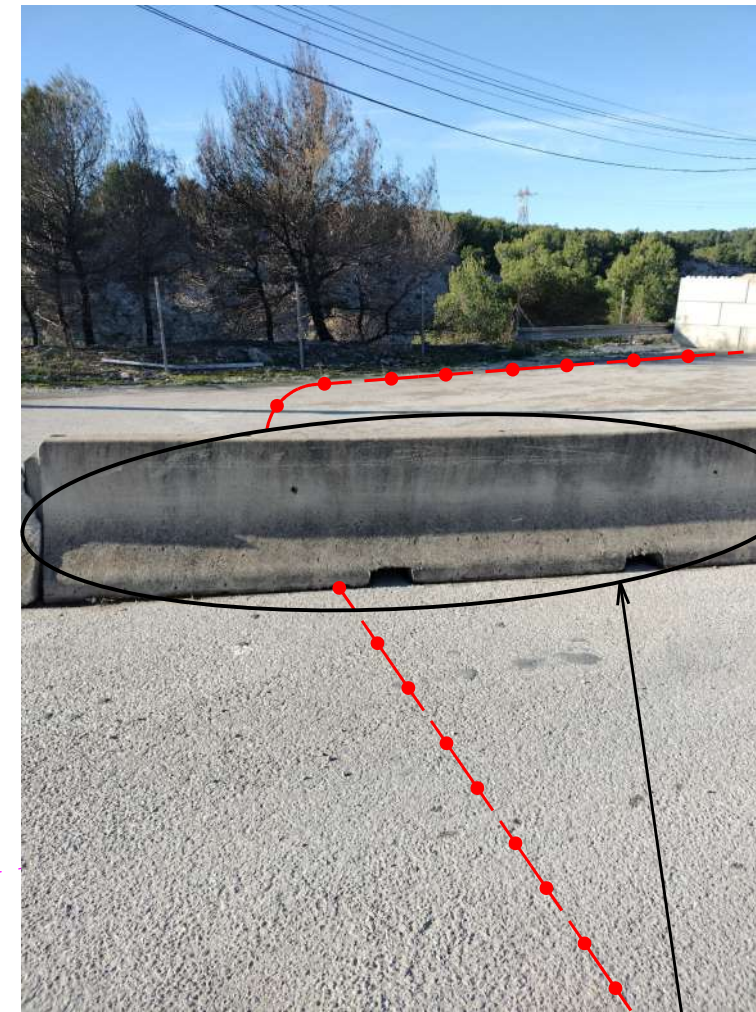
Plot béton existant
