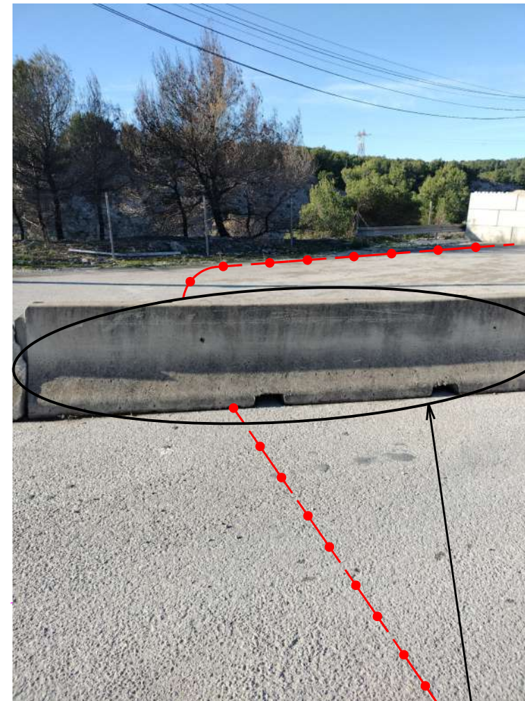
Plot béton existant
